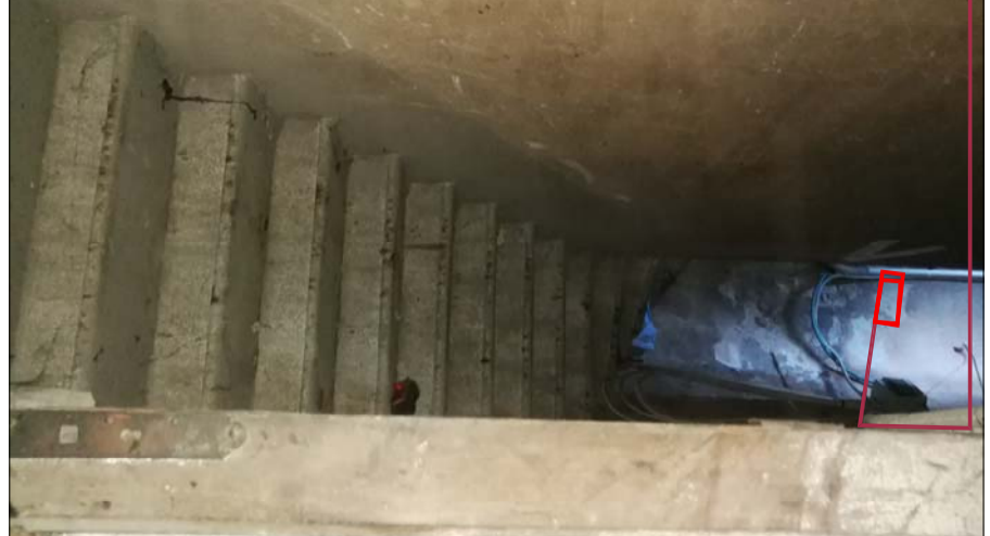
NUOVA VIA CAVI E QUADRETTO ENERGY METER PER CONNESSIONE DEL SISTEMA DI ACCUMULO NEL SOTTOSCALA DEL PIANO INTERRATO
